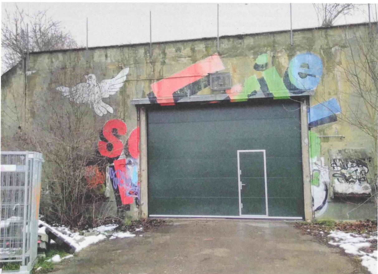
Ehemalige Bunkeranlage in Mutlangen; heute als kommunales Steusalzlager genutzt
